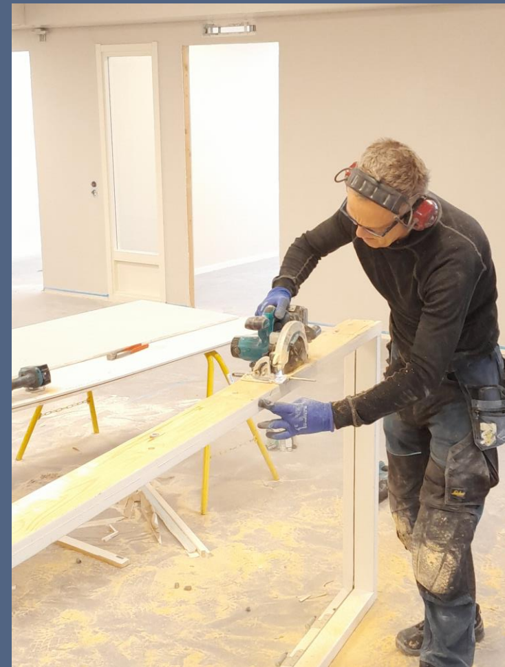
Klyvning av dörrkarm på plats för återbruk
