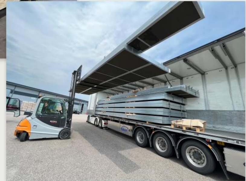
Lastning av EVIA-grunder
