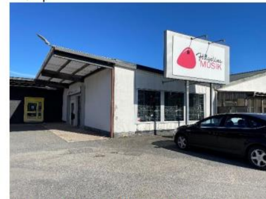
Foto 10. Exempel på byggprodukter för återbruk – skyltbelysning.
